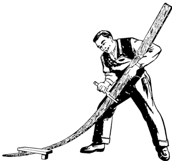
Fig. 31. Bordet böjes och vrides före fastsättningen.
